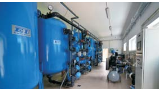
Głównie przebudowano stację uzdatniania wody w miejscowości Płuszczyce-Kolonia
