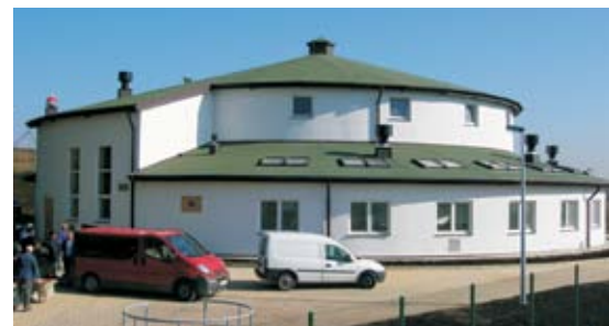
Oczyszczalnia ścieków w Snopkowie w 2007 r. zdobyła „Kryształową Cegłę”
