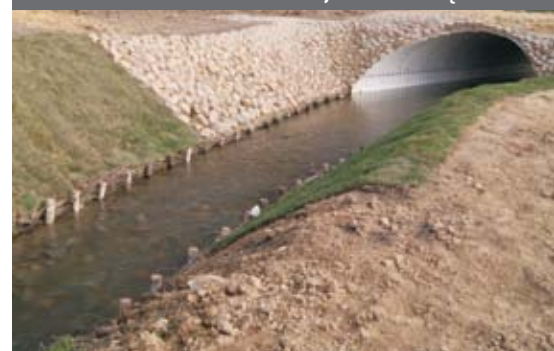
Most na Czechówce w miejscowości Dąbrowica
